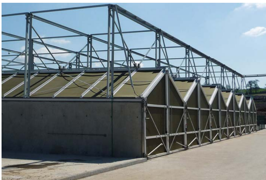
Abbildung 1.4 – Ein Beispiel für ein Kompostierungssystem in überdachten Mieten (mit Blechen abgedeckt)
